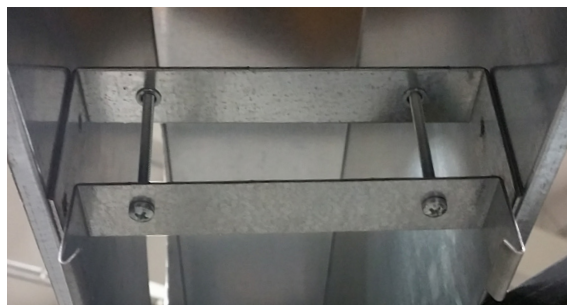
CONTROCAVALLOTTI SCORREVOLI in posizione ottimale per il montaggio del diffusore lineare.
