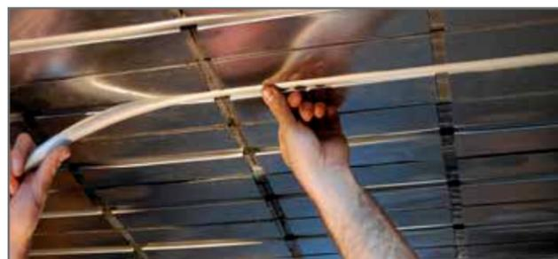
In ultimo l'impianto viene rivestito con lastra in cartongesso fissata sull'orditura secondaria preparata in precedenza.
