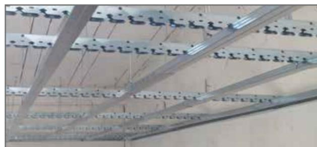
Terminata l'orditura è possibile installare i pannelli del sistema DRY 40 semplicemente incastrandoli tra i montanti dell'orditura secondaria grazie allo speciale profilo di cui sono provvisti.
