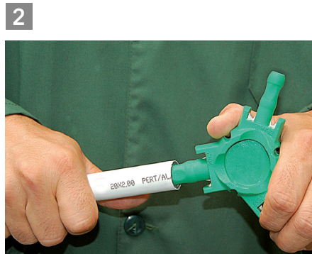
2 CALIBRATE - DEBURR OF THE PIPE / CALIBRAZIONE DEL TUBO / KALIBRIEREN/ ENTGRATEN / CALIBRER ÉBAVURER
